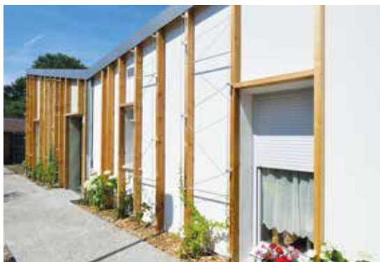
La résidence Le Clos du Village à Escoutpont
